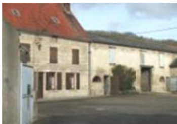
Corps de ferme dans le centre ville de Villers-Saint-Paul
