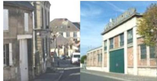
Bâti ancien à Saint-Leu-d'Esserent
