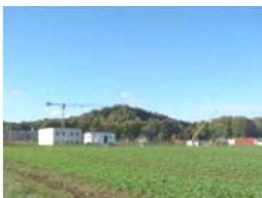
Construction d'une zone d'activités en lisière de Monchy-Saint-Eloi
