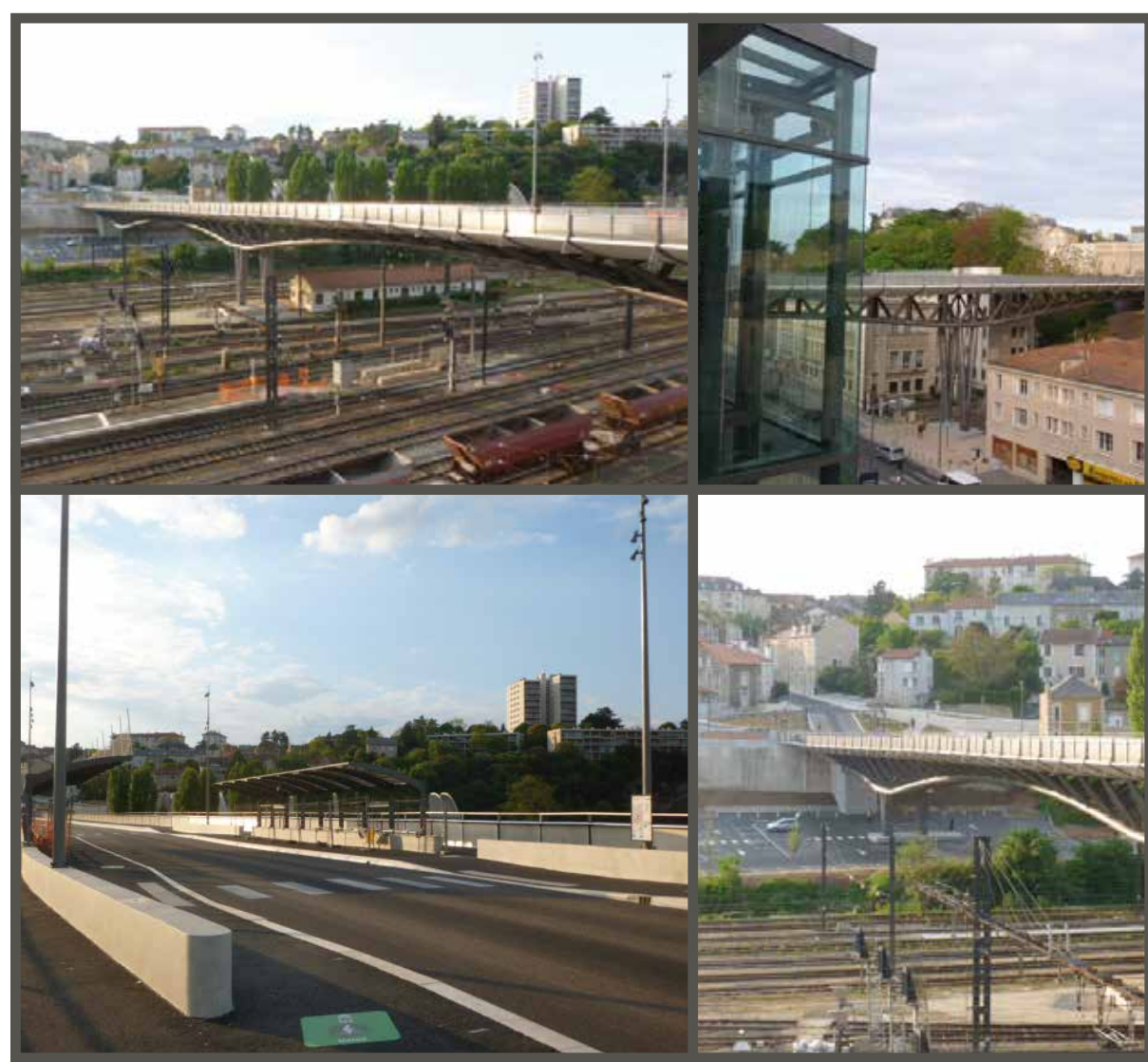
Viaduc des Rocs à Poitiers (86)
