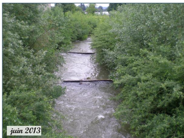
*La passe à poissons d'Andrésy est la 1<sup>ère</sup> passe de type rivière artificielle créée sur une rivière navigable de l'importance de la Seine. L'utilisation de techniques végétales a permis de renforcer les berges et près de 3 000 arbres et arbustes ont été replantés après les travaux.*
