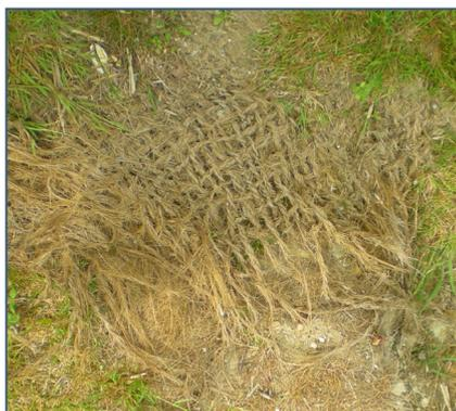
Geotextile permettant de fixer et remodeler les talus des pointes de l'île
