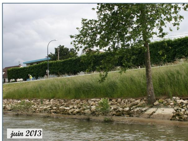
*Ces berges avaient fait l'objet de travaux par le SFVS en 2006 (pose de palplanches d'étanchéité) et le projet a été repris par le SMSO pour réaliser l'ensemble des profils, cheminements, protection et plantations côté Seine.*
